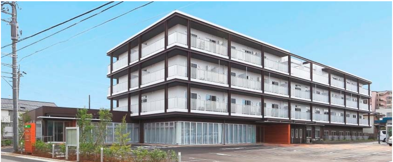
「コープみらいえ四街道」外観
