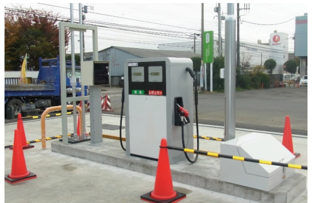
「コープデリ習志野センター」に 設置した自家給油施設
