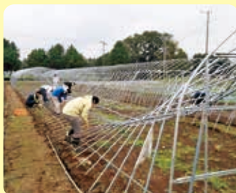
台風被害で倒れたハウスを修理
