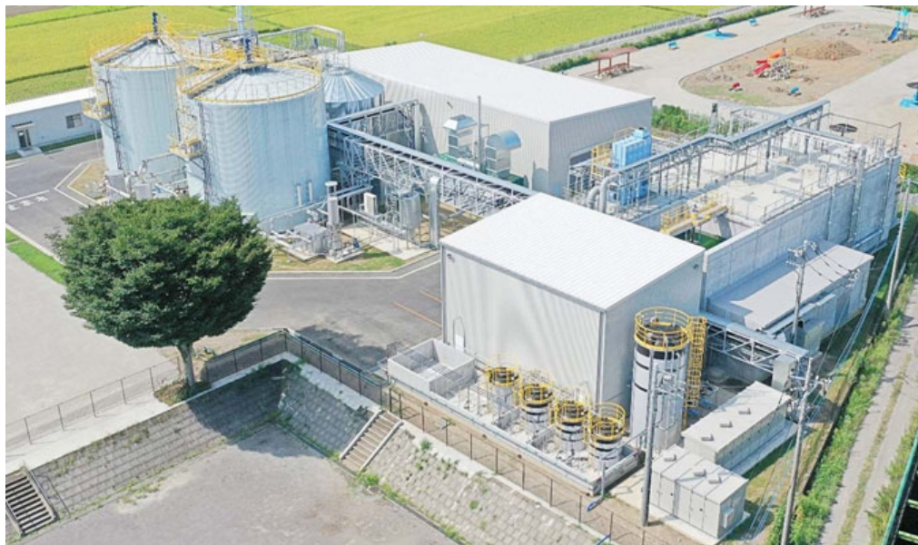
NEFC バイオガス発電プラント全景
