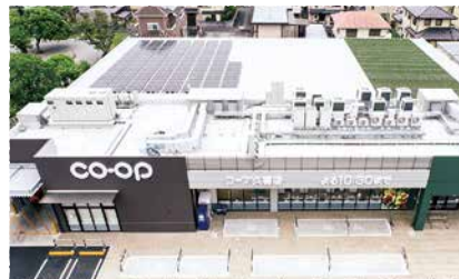
店舗に設置した太陽光発電パネルと屋上緑化
